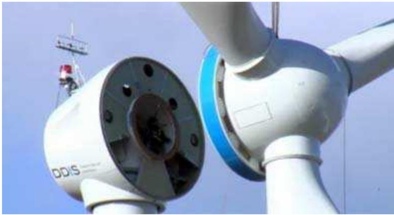
Pour l'instant, ce prototype d'une puissance de 800 kW et d'une envergure de 60 mètres est doté d'une nacelle de 45 tonnes. Cette éolienne « pilote » levée à Onnaing n'a pas pour objectif d'être la plus haute ou la plus puissante.
