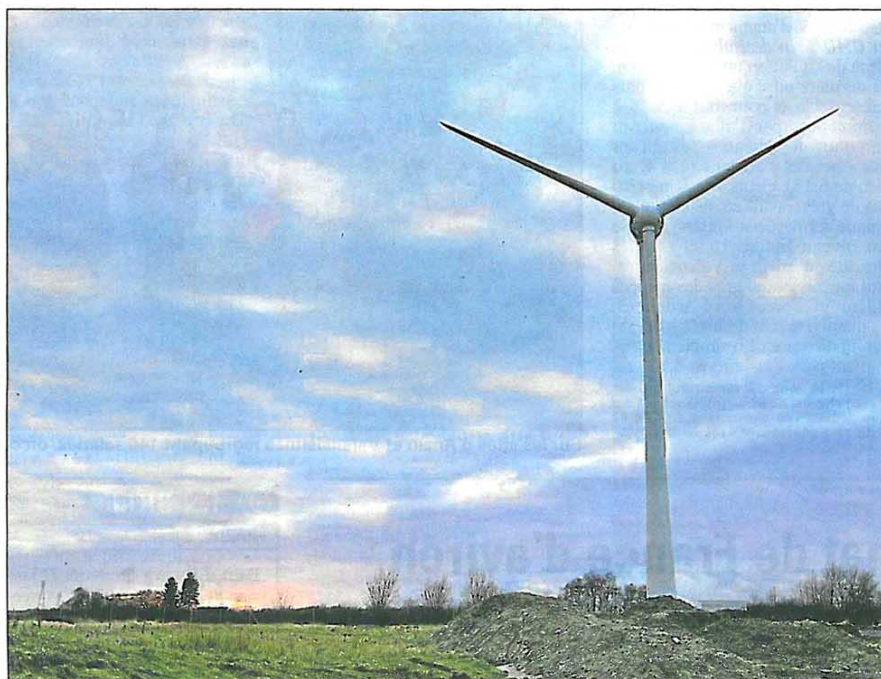
L'éolienne est située en bordure d'autoroute, le long de la zone dite Toyota.
